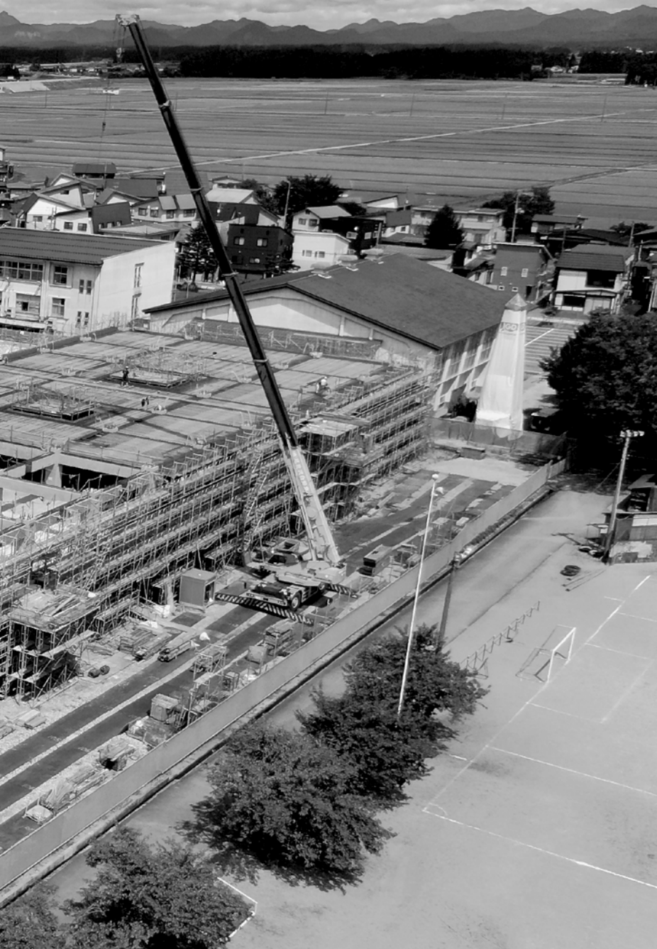
▲建設中の明倫学園(写真提供:株式会社本間利雄設計事務所)
