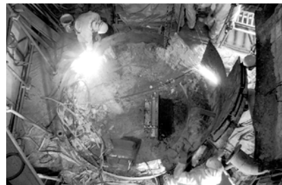
▲エコプラザもがみ大規模修繕(ガス冷却室)
