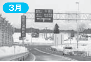
▲国道13号新庄北道路開通。(3月26日)
