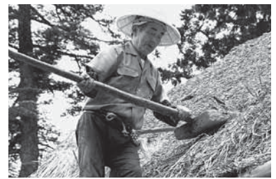
▶旧矢作家住宅の屋根ふきかえの様子
