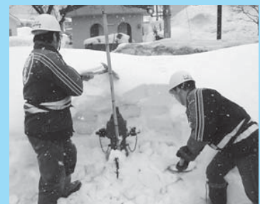
▲消防団員が消火栓の除雪
