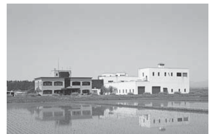
▲新庄市浄化センター
